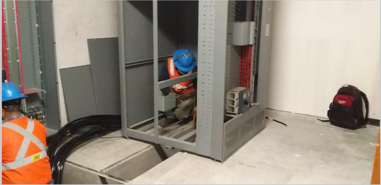
Instalación de tableros principales de distribución
