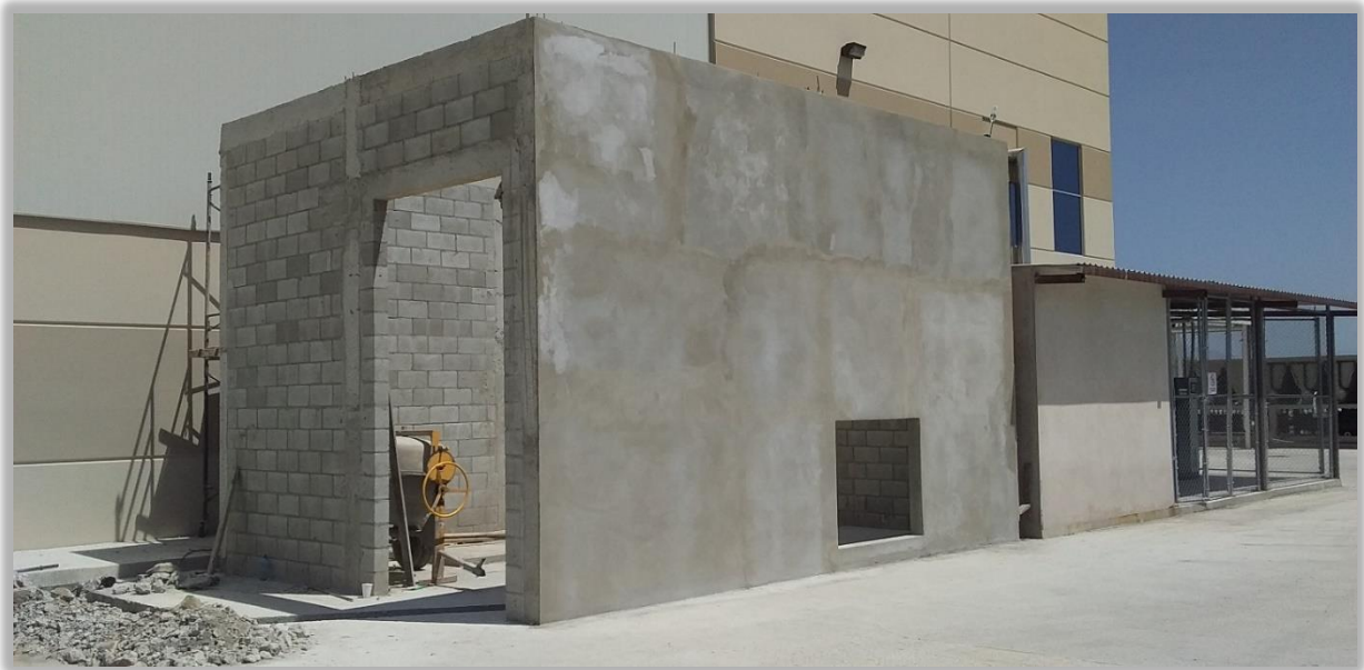
Construcción de muros, revocado/aplanado para acabado final
