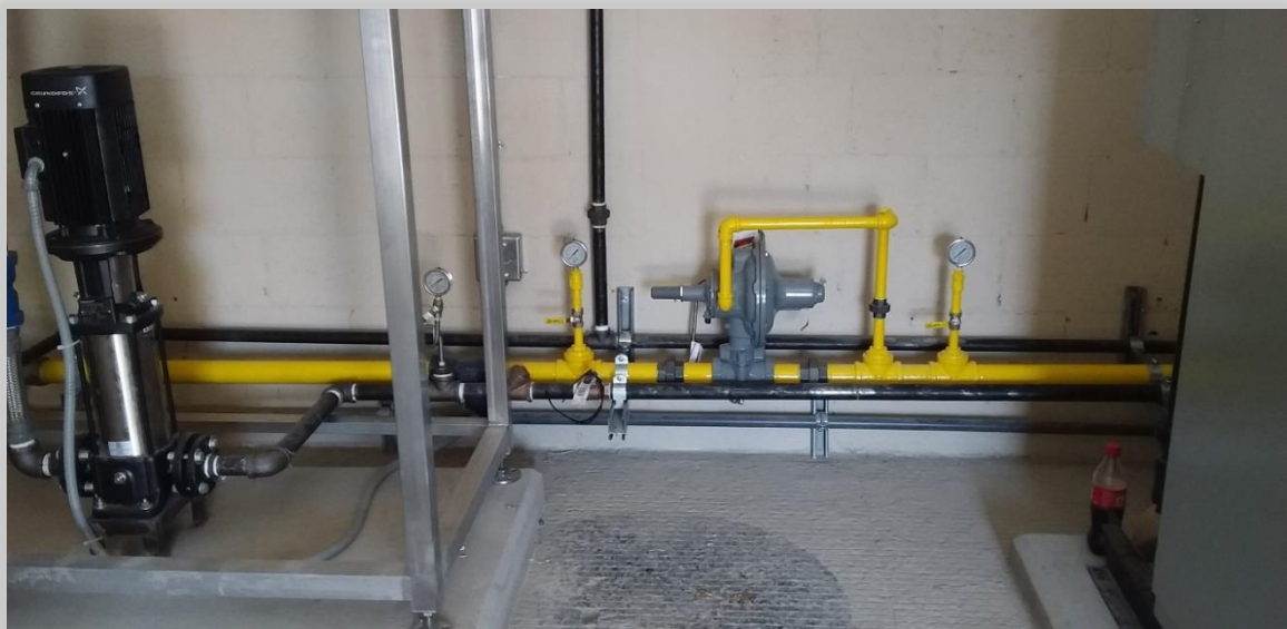
Instalación de tuberías para suministro de gas, agua, hacia caldera
