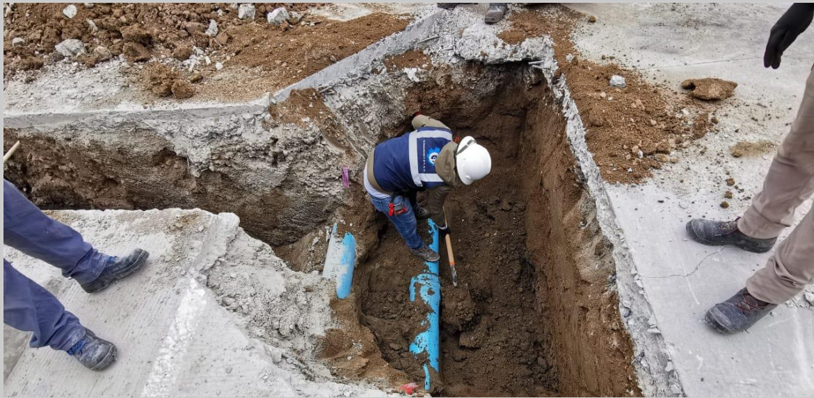
Entronque con sistema existente contra incendio
