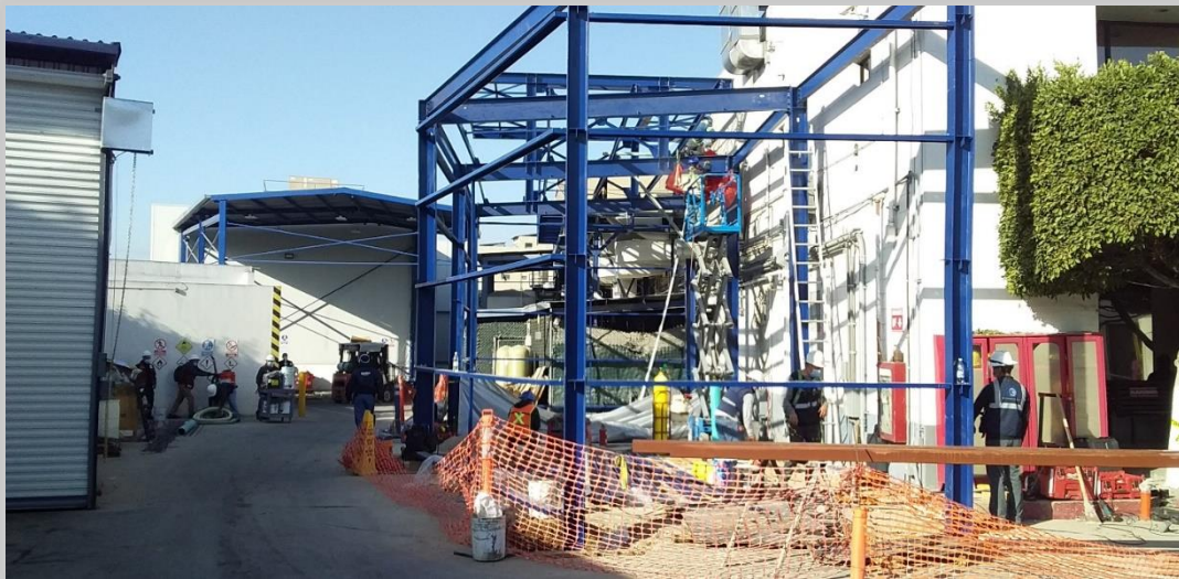
Construcción de estructura para expansión GEIDA 2.5
