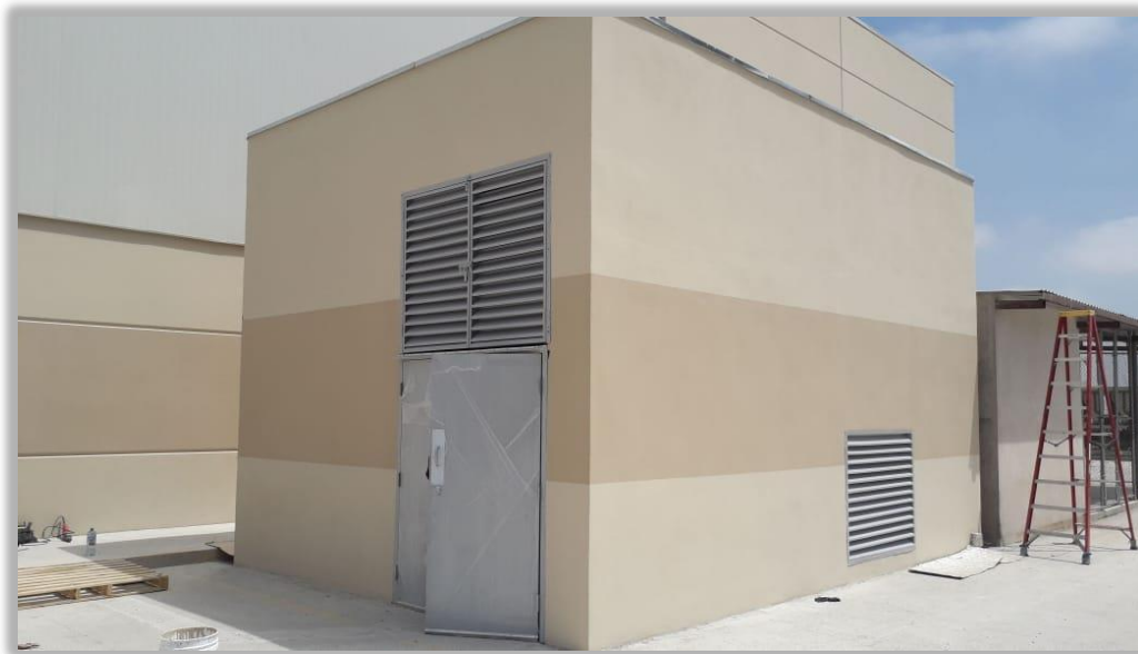
Cuarto de calderas
