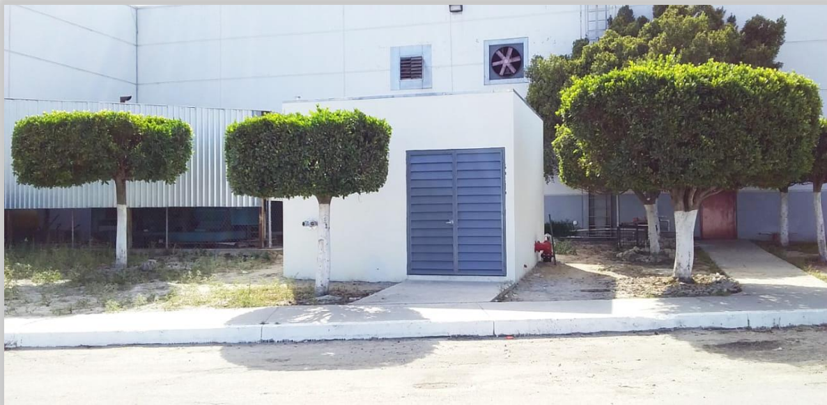
Cuarto de bombeo contra incendio
