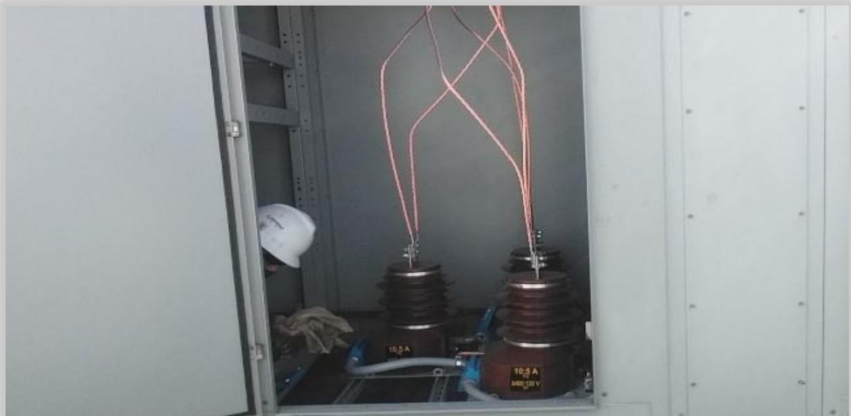
Instalación de transformadores integrados de medición
