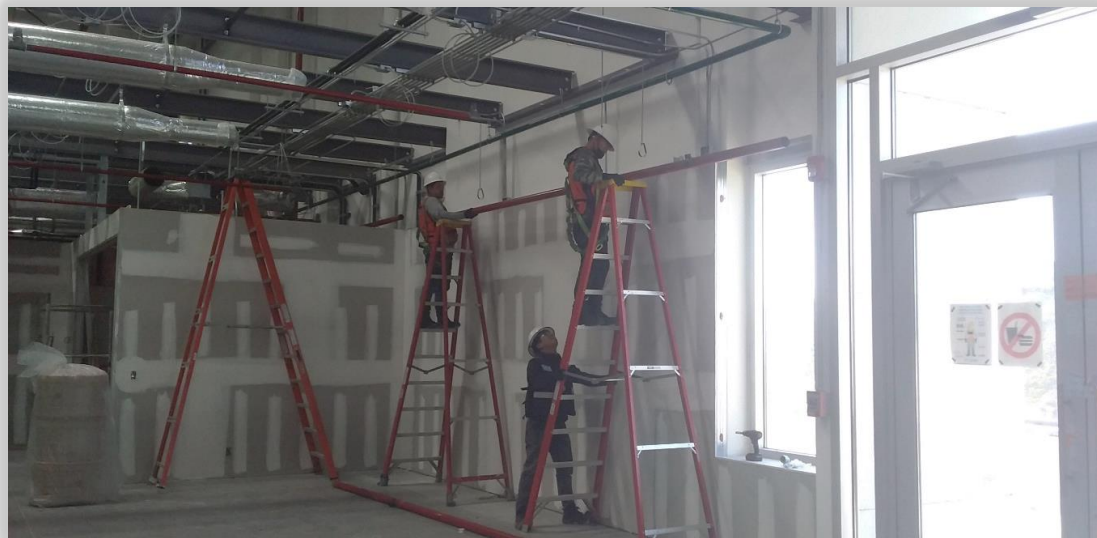
Colocación línea de cabezal principal de alimentación
