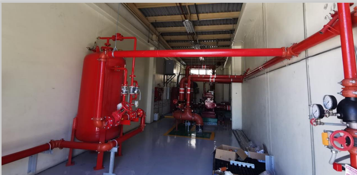
Instalación de tanque tipo membrana
