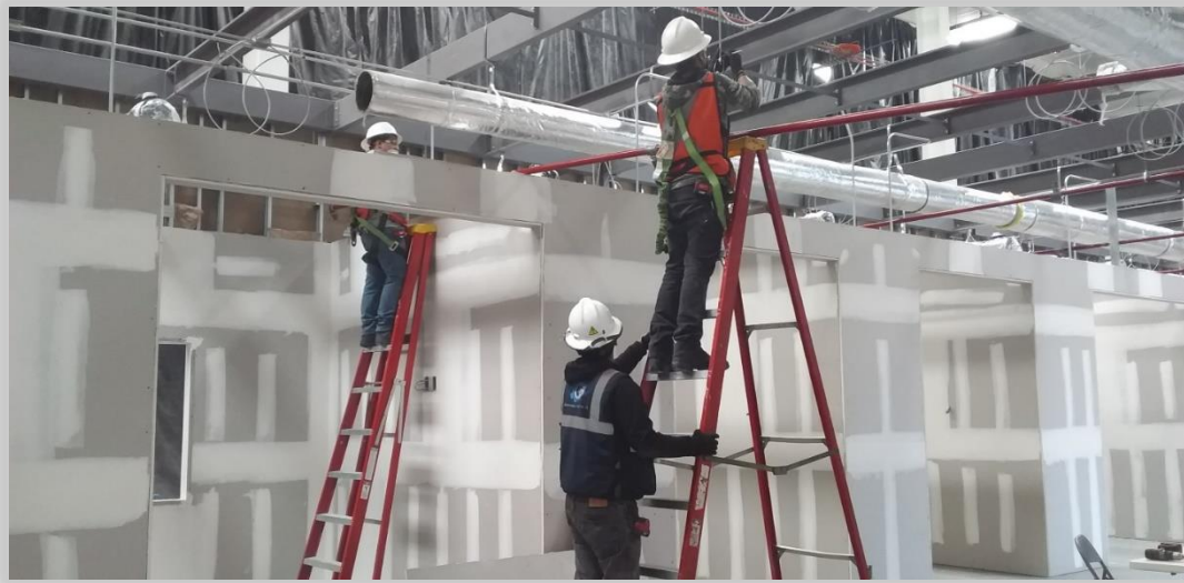
Alineación y colocación de rociadores
