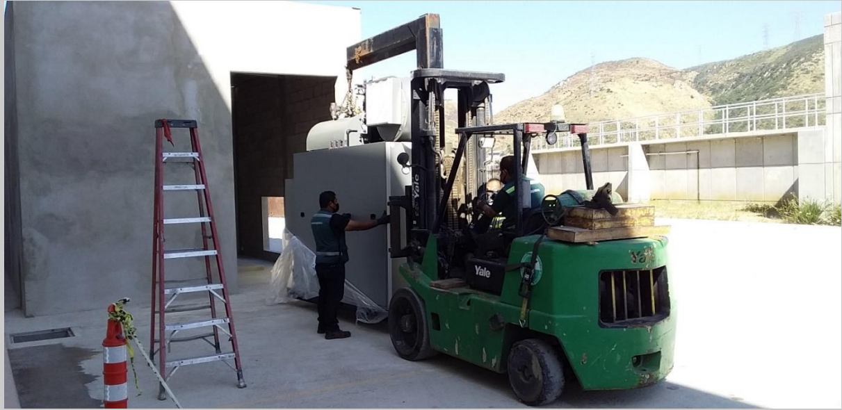
Maniobra para ubicación de calera dentro de cuarto de trabajo
